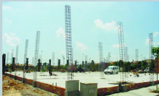
Aspecte de les obres
